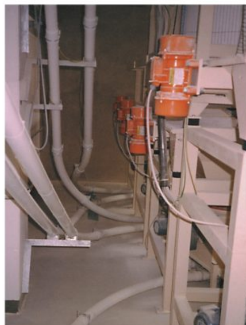
Förderspiralanlage mit Big-Bag Entleerstationen
